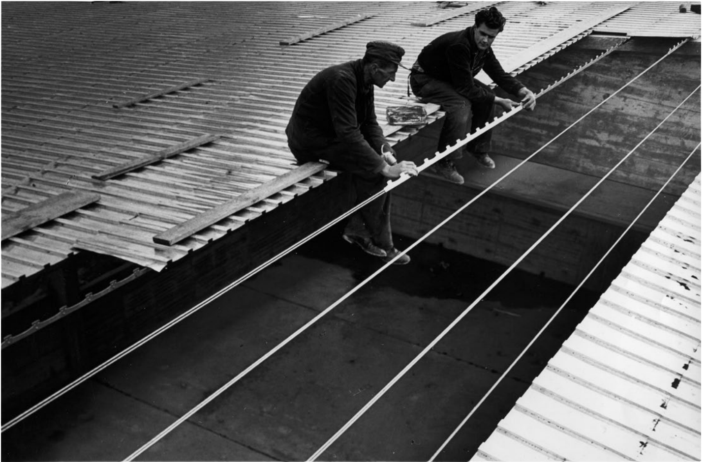
Fural auf Spannstahldrähnen. Die Furalhalter sind an doppelt geführte Drähte geklemmt, womit Spannweiten von bis zu 15 m überbrückt werden können. Die Abbildung zeigt vermutlich die Fasslagerhalle der ÖBB in Inzersdorf (A), wo das Dach noch heute existiert. – Bild: Staatsarchiv Uri, Altdorf; PA «Nachlass Josef Furrer-Gisler (1910–1976) / FURAL»
