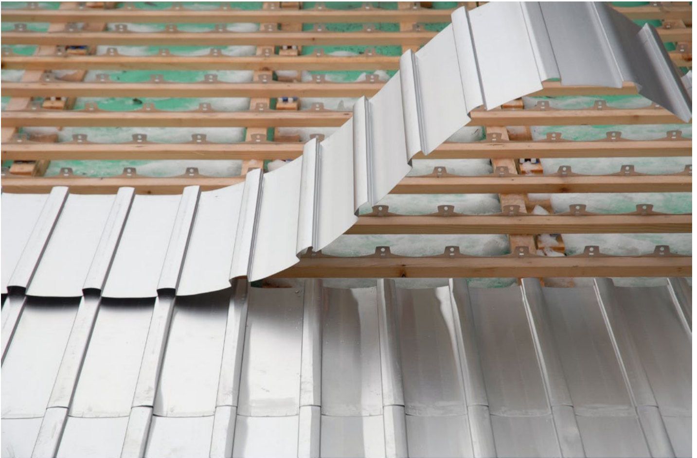
Montage des neu hergestellten Furalbandes auf dem Dach der Schulanlage Untermoos. Durch das Abrollen verkrallt sich das Blech mit der identisch profilierten Unterkonstruktion und hält ohne weitere Verschraubungen. – Bild: Roger Frei
