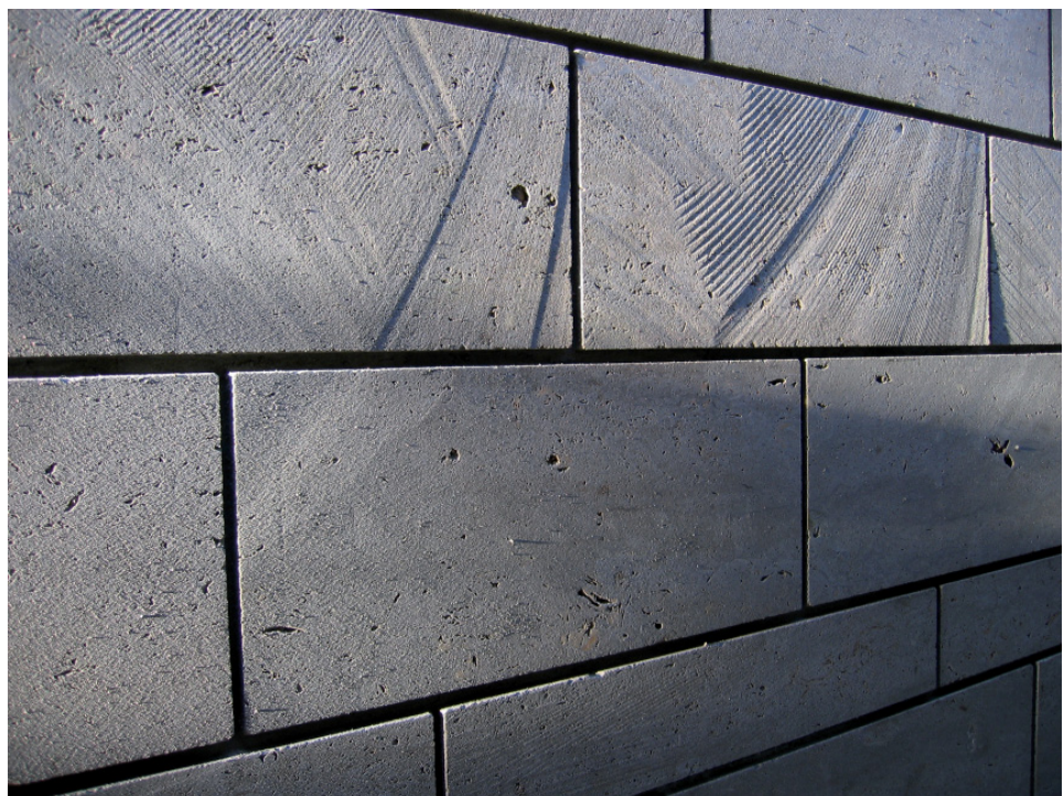
Im Streiflicht deutlich zu erkennen: Das «Flattern» des Sägeblattes hinterlässt radiale Spuren.
